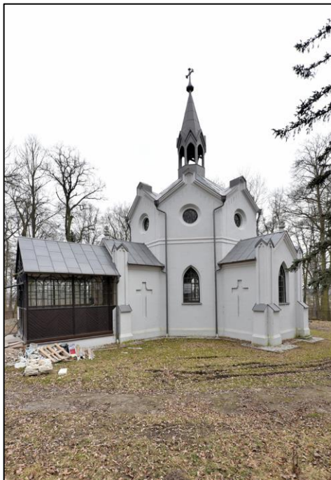
Kaplica od północnego-zachodu
